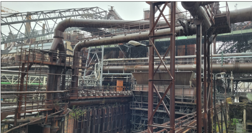
Abb 4: Blick vom Ende der Kokerei auf die Hochöfenbatterie
